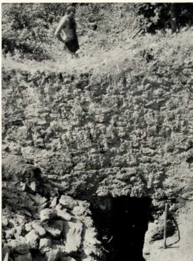
2. A mészégető kibontott tüzelőnyílása belülről
