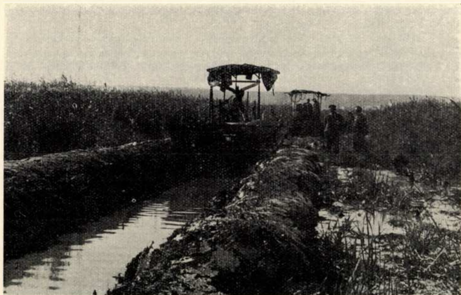
Ároknyitó eke munka közben
