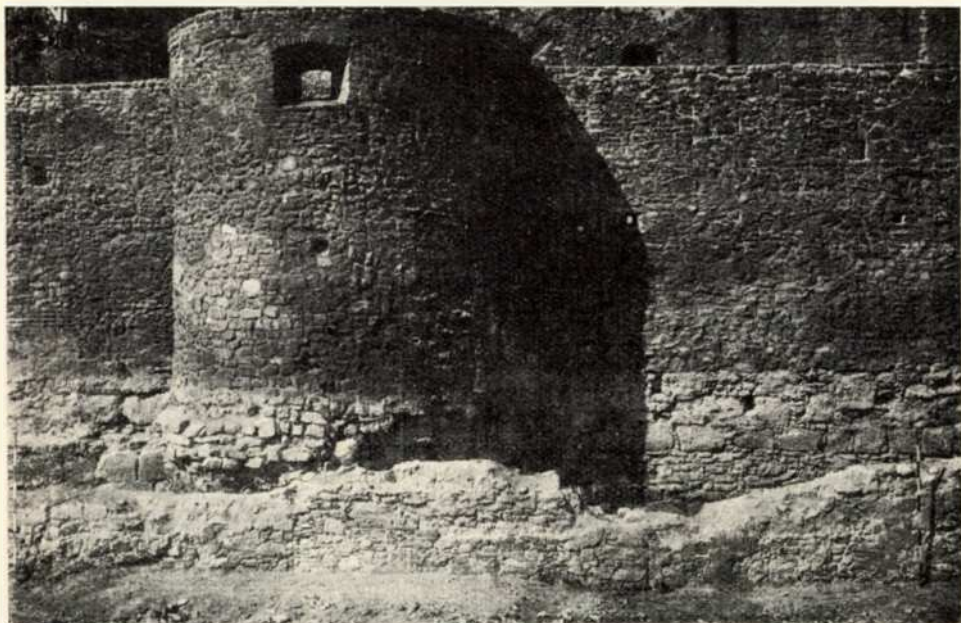
7. A kijavított római városfalra épített középső városfal (ásatás után)
