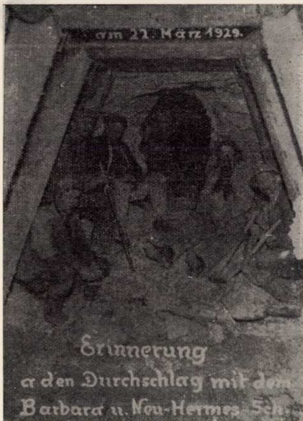
Az Új Hermes és Borbála akna 600 m hosszú szállítójáratának találkozásakor készült csoportkép. 1929. III. 22.
