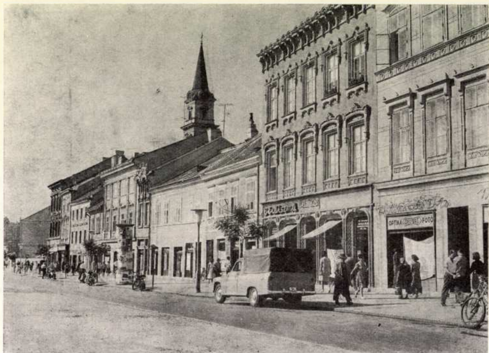
A Lenin körút felújított homlokzatai
