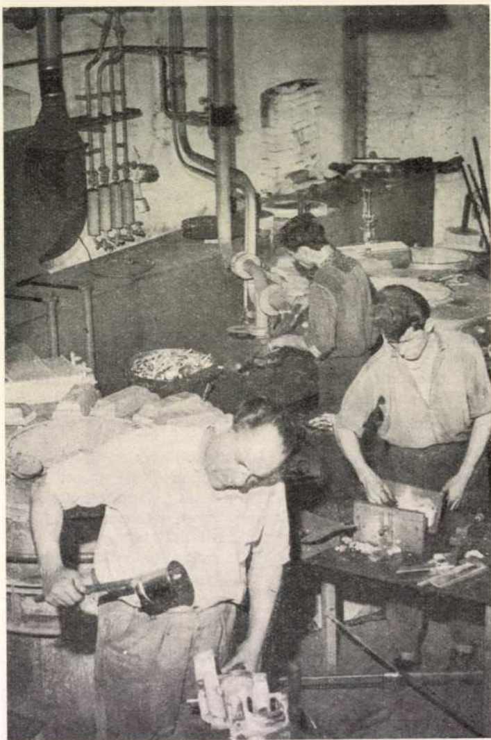
Kokilla öntés gázzal fűtött kemencében 1968. május
