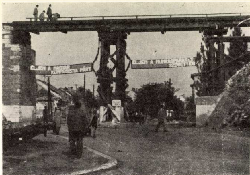
Vasúti felüljáró a Győri úton (1946)
