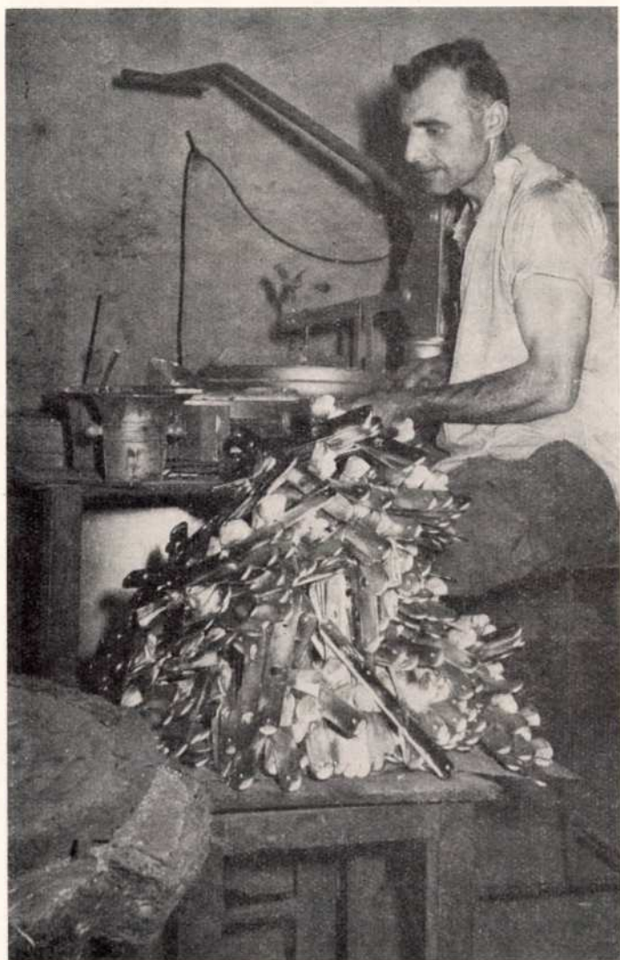
Ajtókilincs-cím kokilla öntése elektromos fűtésű kemencében. 1967
