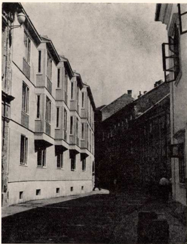
10. kép. A kétemeletes lakóház lépcsősen tagolt utcai homlokzatát a szabálytalan beépítési vonal indokolja (Szt. György u. 18. sz.)
