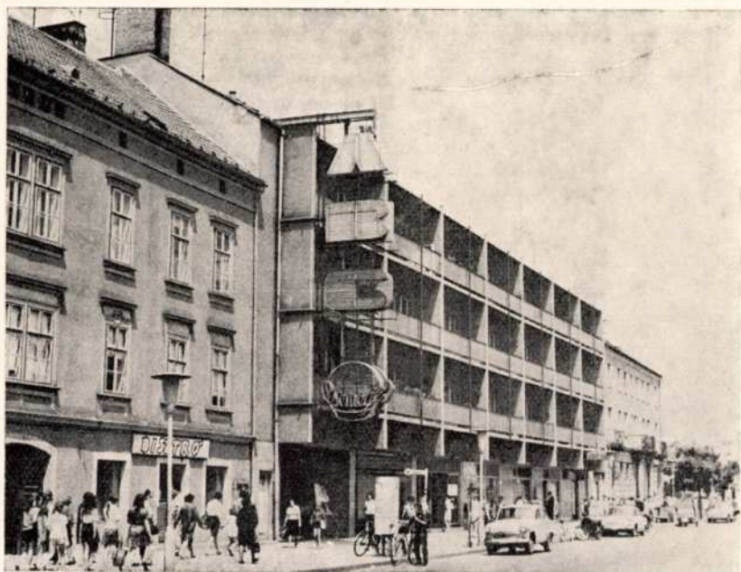
13. kép: Az ABC áruháznak a Lenin körüti házaktól elütő frontosságát az emeletek összefüggő erkélysorai még jobban hangsúlyozzák
