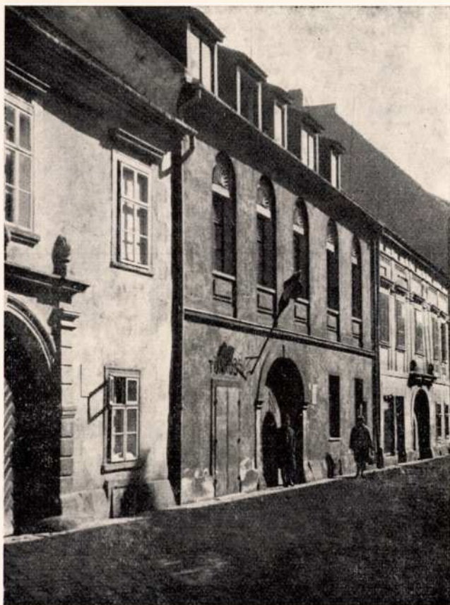
18. kép: Tetőtér beépítés műemléképületben (Kolostor u. 7. sz.)
