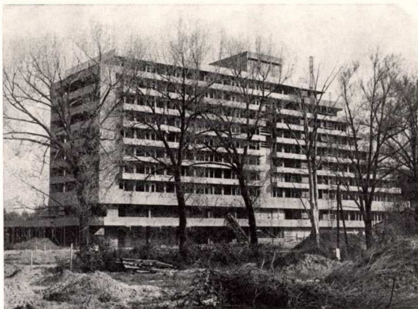
24. kép: Az épülő 600 ágyas üdülőszálló a Szabadság körúton
