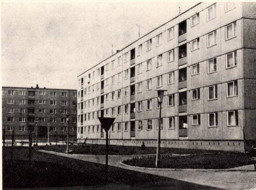
19. kép: Kőfaragó téri lakótelep: házgyári elemekkel épült házsorok
