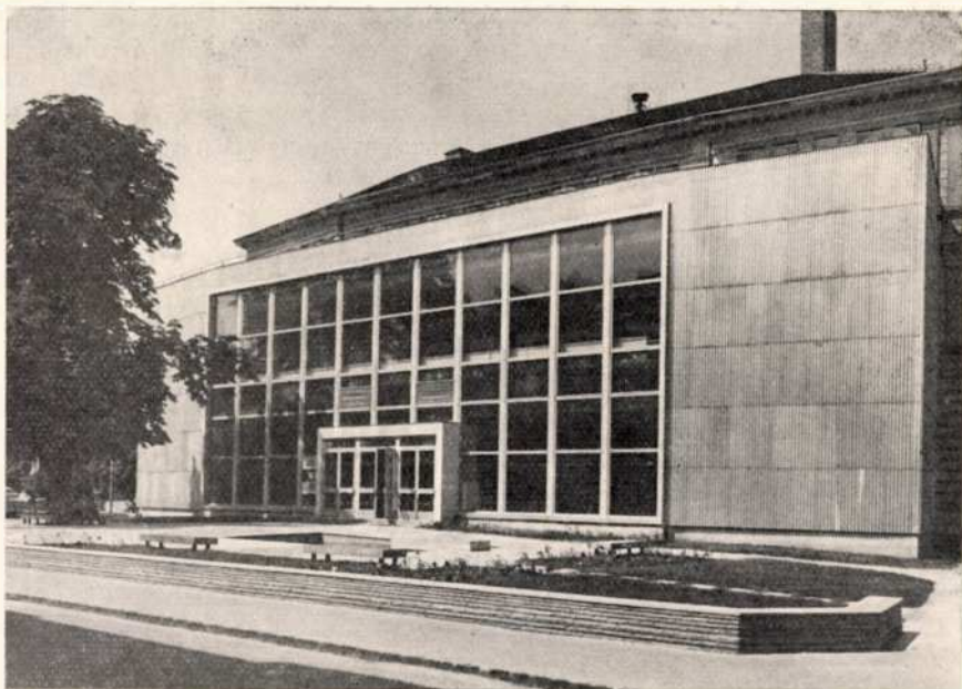
25. kép: A Liszt Ferenc Művelődési Központ főbejárata a rekonstrukció során a Templom utcára került, redőzött alumíniumlemez burkolatú épületrészben
