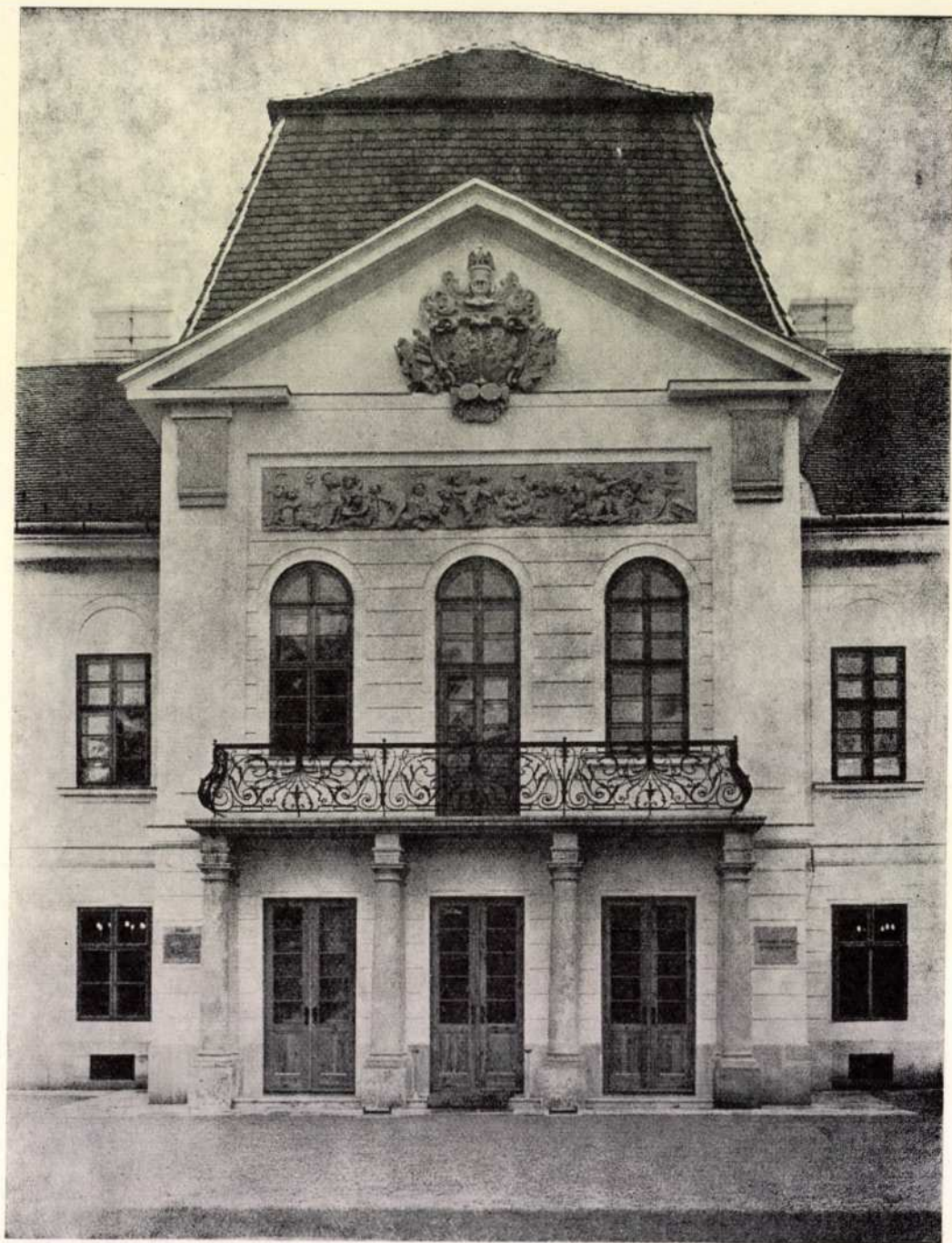
Az újjáépített homlokzat (Adorján Attila felvétele)
