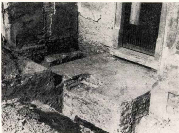
17. A tervezett nyugati torony alapozása
