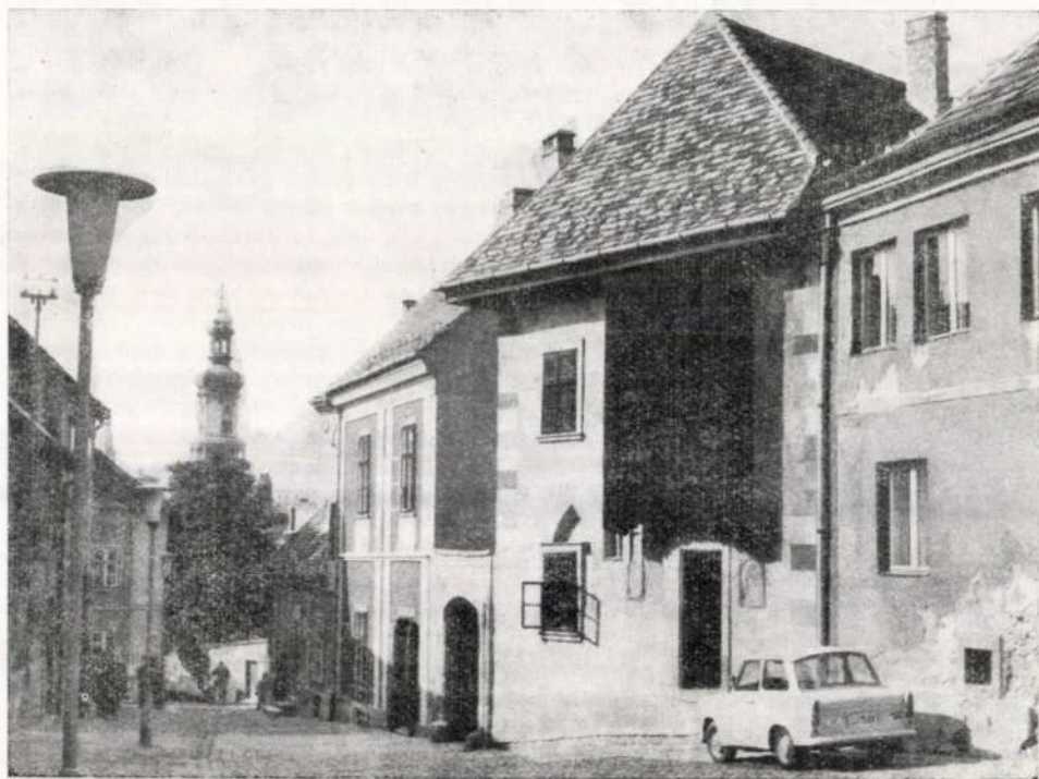
5. A Pozsonyi út 3. sz. ház: jó példa a történeti hitelességnek megfelelő rekonstrukcióra
