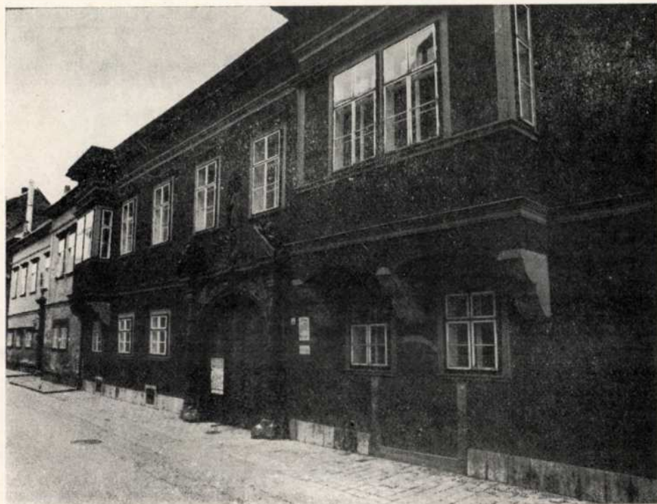
1. Az épület helyreállított homlokzata
