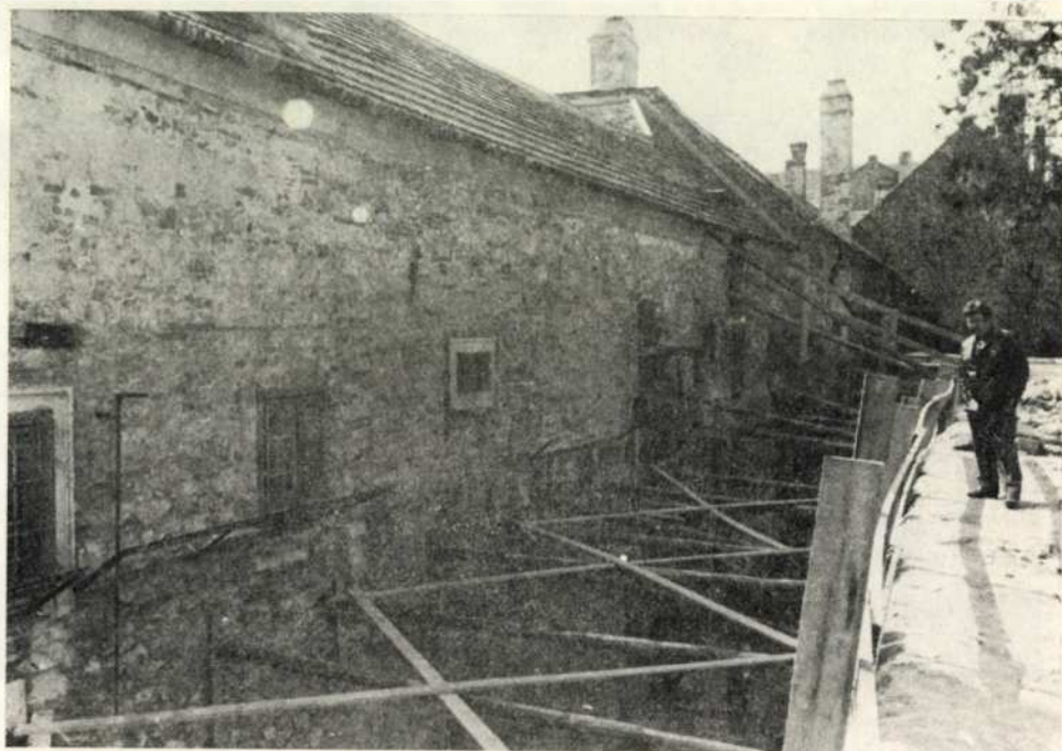
5. Az épület bástyakert felőli udvarának feltárása
