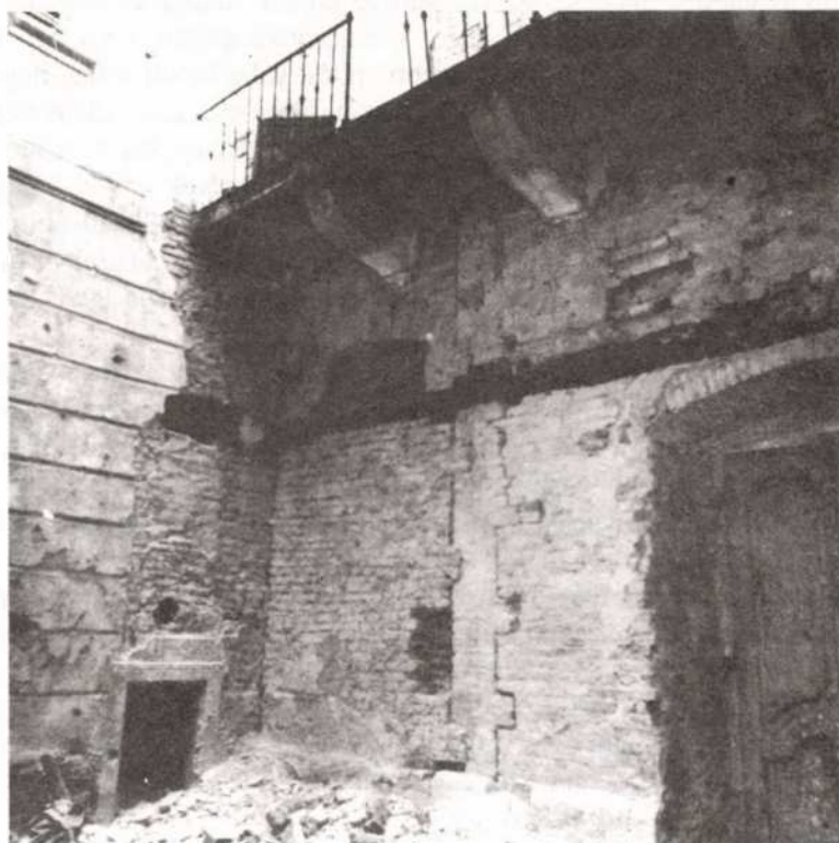
Nyugati világító udvar – földszinti, feltárási állapot
