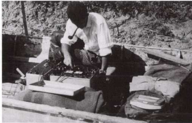
11. Fertői geoelektromos mérés a Ge-20-as típusú ellenállásmérő műszerrel. A műszer alumínium csónakban van, a mérőelektródák a csatorna partjába vannak szúrva. A műszer mellett Holló Lajos pipázik.
