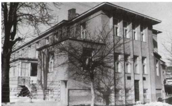
12. A Laboratórium épülete a Múzeum, ma Csatkai utcában 1959-1973 között.
