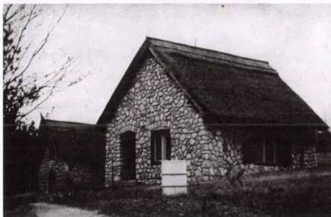
5. A Nagycenki Geofizikai Obszervatórium mészkőből készült, náddal fedett mágneses épületei, elől az abszolút ház, hátul az egyik elsőnek elkészült épület, a relatív ház.
