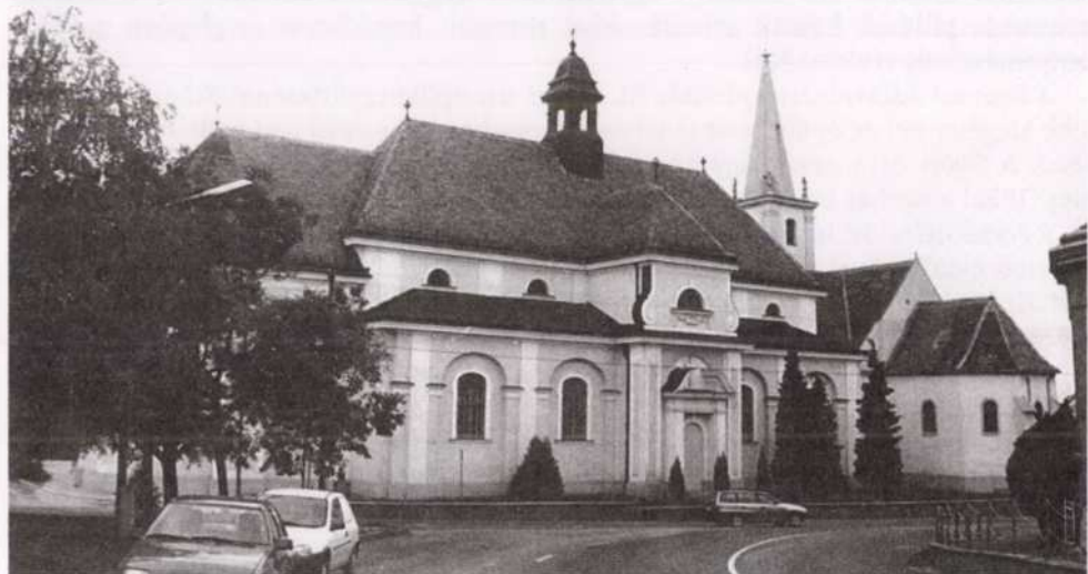
A Fertőszentmiklóson 1925–1935 épült r.kat templombővítése
