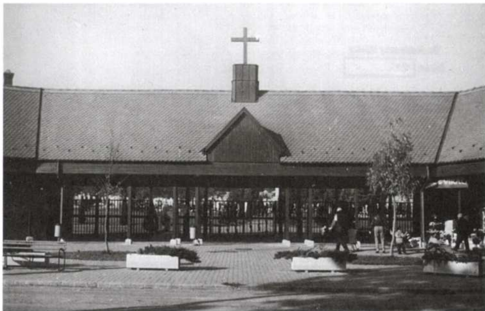
21. A Szent Mihály temető Pozsonyi úti bejárata. 1993. Solt Herbert építész terve.
