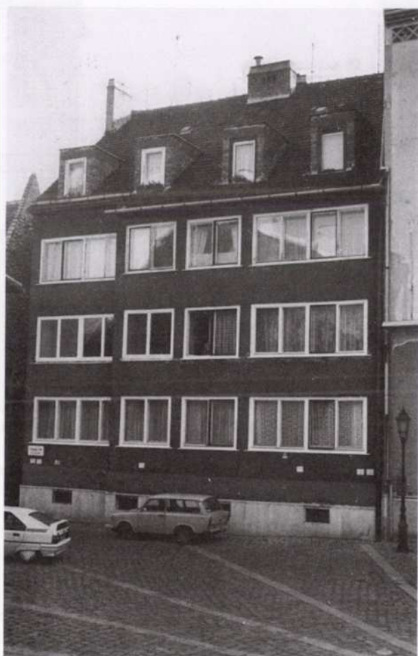
13. Foghíjbeépítés az ún. „Gyóni ház” helyén az Orsolya téren. 1962. Erdeős László (GyTV) építész terve.
