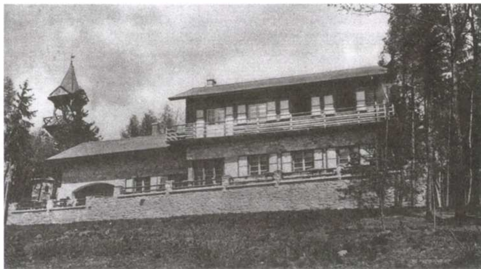
9. A Muck-kilátó Schiller János soproni építőmester alkotása, előterében a Winkler Oszkár építész tervei szerint 1938-ban épült István menedékház áll.
