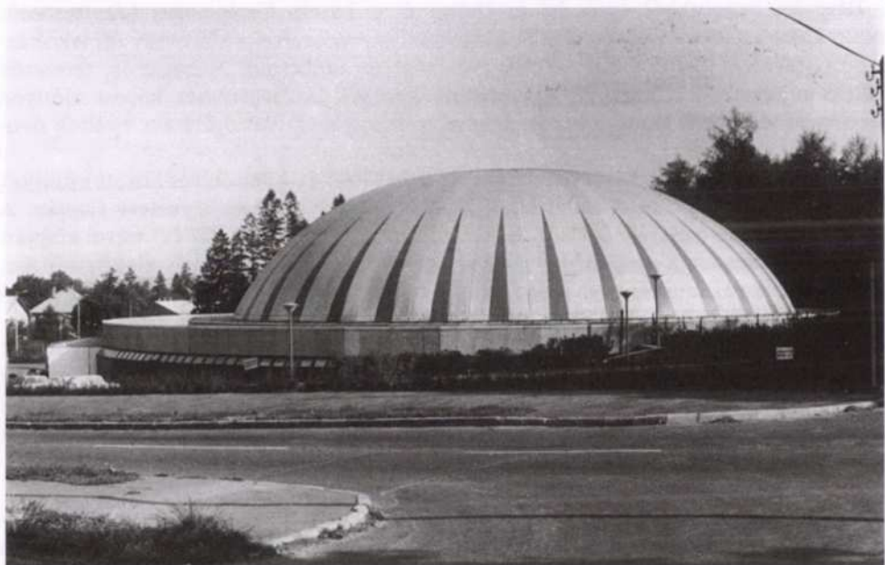
17. A Lőver uszoda Graboplast kupolával fedett csarnoka, 1975–77. Tolnay Lajos (GyTV) építész terve.
