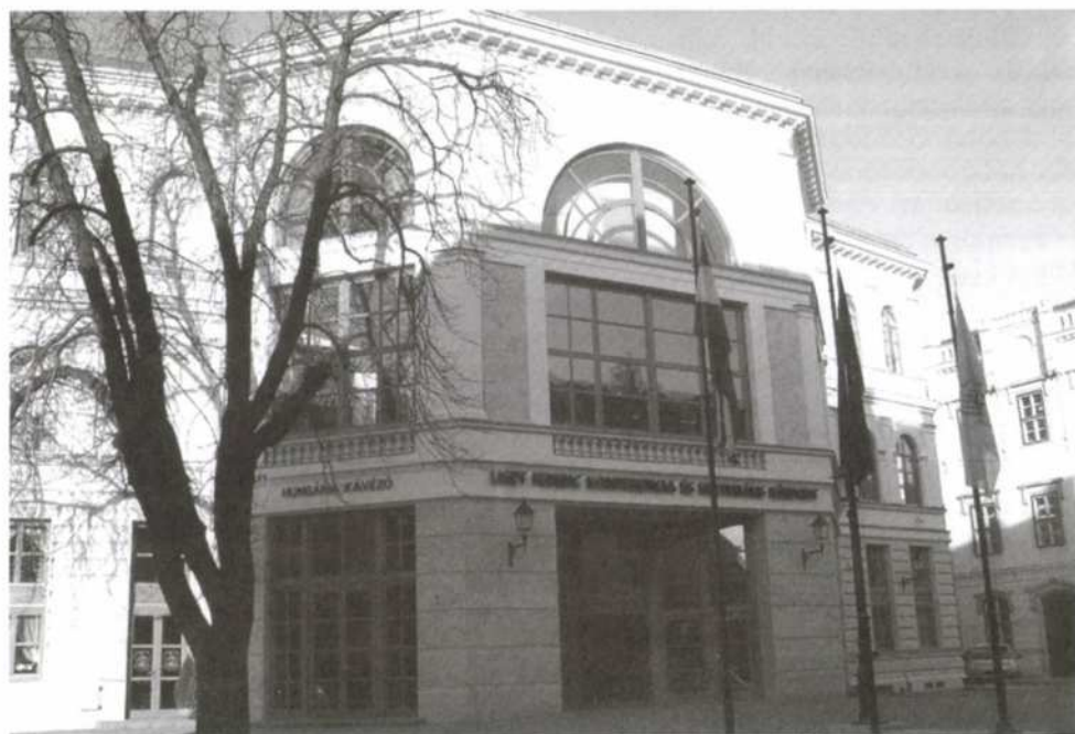
10. kép Az új Templom utcai homlokzat a főbejárattal
