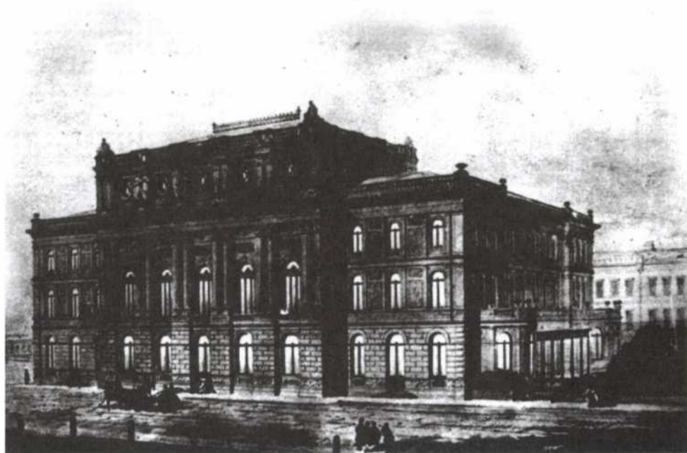
4. kép: A soproni Vigadó- és Kaszinó tervezett épületének távlati képe (ismeretlen szerző terve)
