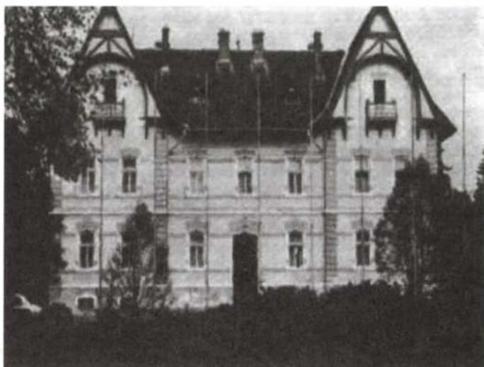
1. kép. A Temesvár–Vadászerdei M. Kir. Erdőőri Szakiskola főépülete
