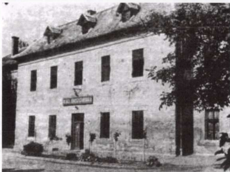
3. kép. A M. Kir. Erdőgazdasági Szakiskola esztergomi épülete
