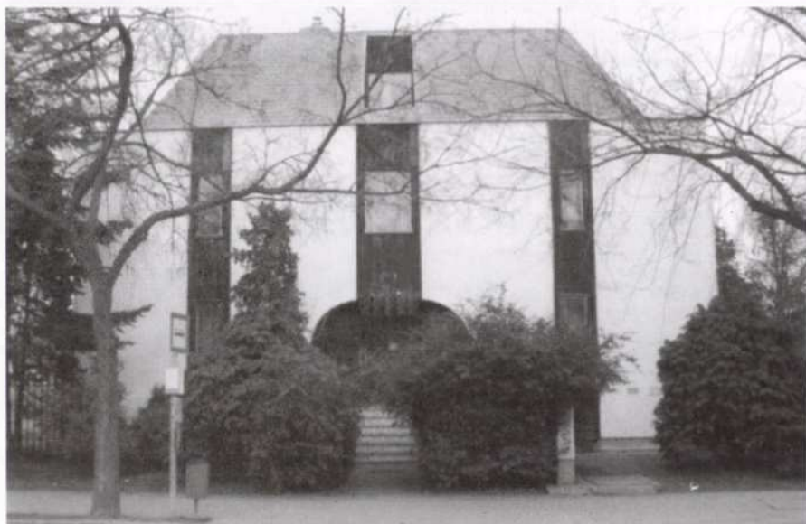
14. kép: A modern építészet jegyében épült a 24. számú ház. Kerítés itt nem készült, de az ültetett örökzöld fák már az emeletig nőttek.
