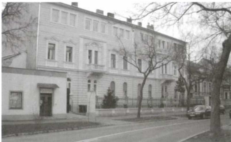
10. kép: A Kossuth u. 7-9. épület a homlokzati felújítás nyomán kellemes benyomást kelt. A porta elbontása után visszaépíthető volna az egykori kapuoszlop és a kovácsoltvas kapuzat.
