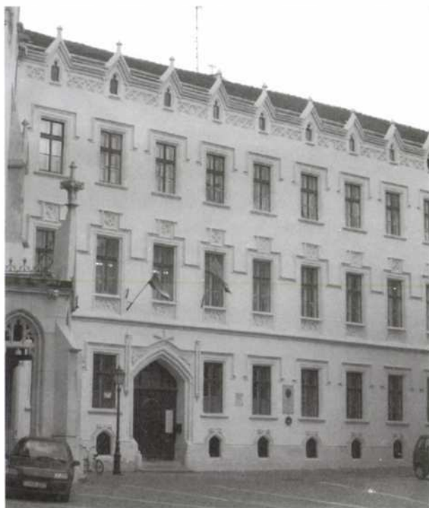
5. kép Az iskolaépület homlokzata az 1884-es bővítés után
