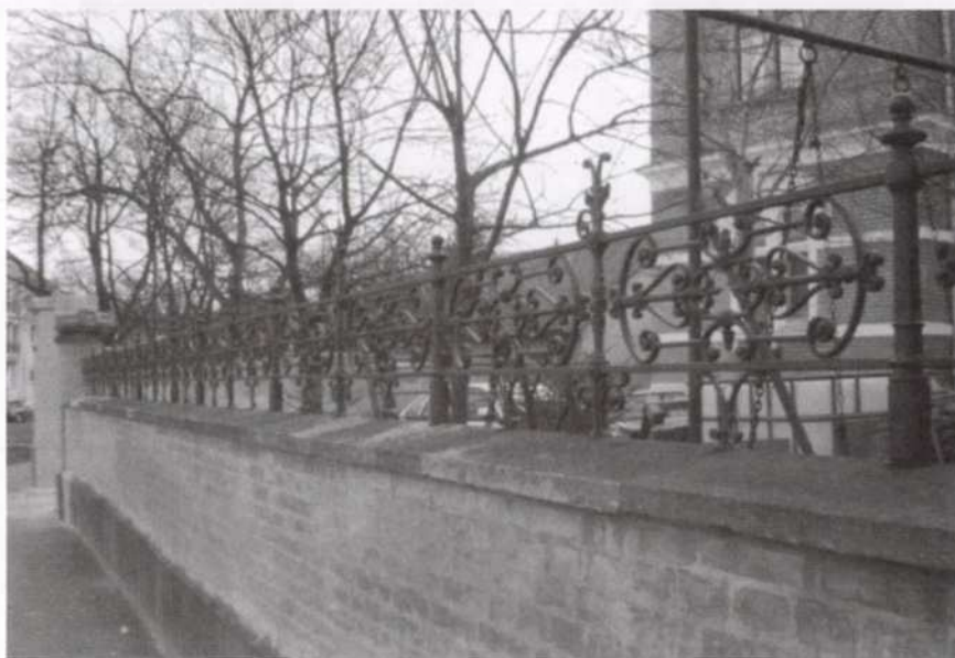
9. kép: A 3. számú lakóépület különleges kovácsoltvas kerítését már helyreállították, csak az eredeti kapuk hiányoznak
