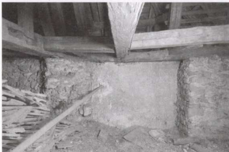
8. ábra A szentély északi fala. Balra az eredeti poligonális szentélyzáradék visszabontott csonkja, jobbra a barokk szentélyzáradék falazata. Középen a barokk átépítés előtti időből származó, vakolt, egykor homlokzatként megjelenő falmaradvány (fotó: Ágh András, 2005.).
