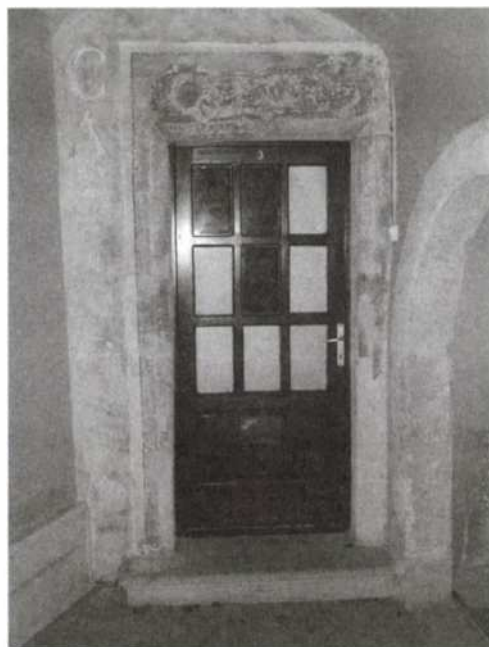
3. kép. Várkerület 17. Az 1531-ben épült házrész bejárata a helyreállítás után.
