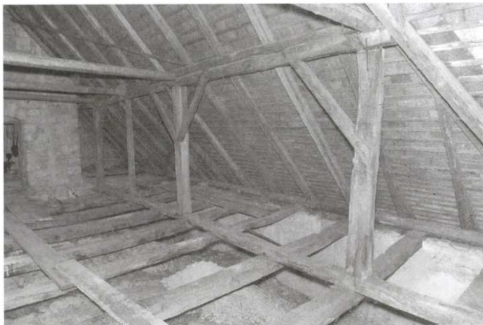
14. ábra A sopronhorpácsi templom hajója feletti tetőszerkezet. Előtérben az 1950-es években egy szakasszal nyugatabbra helyezett székoszlop (fotó: Sarkadi Márton, 2007.).
