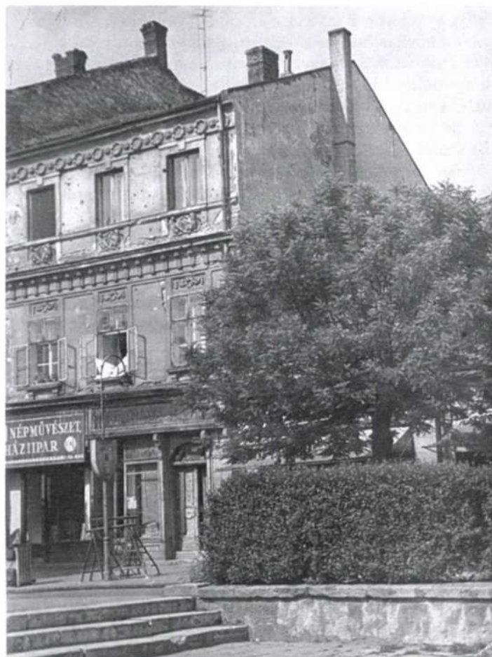
8. kép. A felújítás előtti állapot 1959-ben (KÖH Fotótár)
