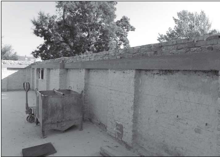
6. kép. A fedélszéket fogadó koszorú már elkészült.
