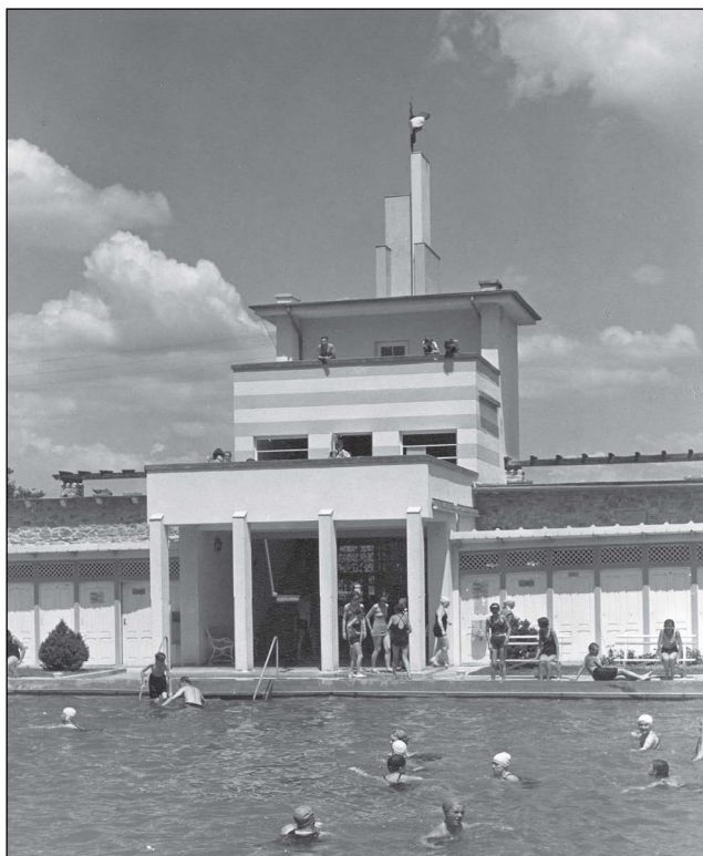
8. kép. A Löver uszoda (1934) bejárati épülete a medence felől. Soproni Múzeum Fotótára
