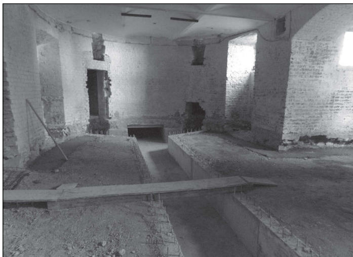
4. kép. Készülő lépcsatorna aknák a konyha padlója alatt
