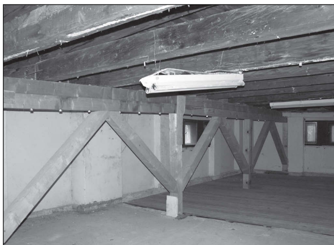
3. kép. A keleti szárny tetőszerkezetének ideiglenes alátámasztása. A dúcolat a pincefödémre viszi a tető terhet.
