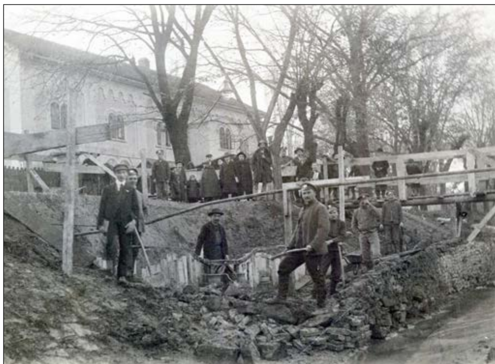
7. kép. Az Ikvahíd helyreállítási munkái orosz hadifoglyokkal. Fotós: Gantner Antal, 1915 őszi (Soproni Múzeum)
