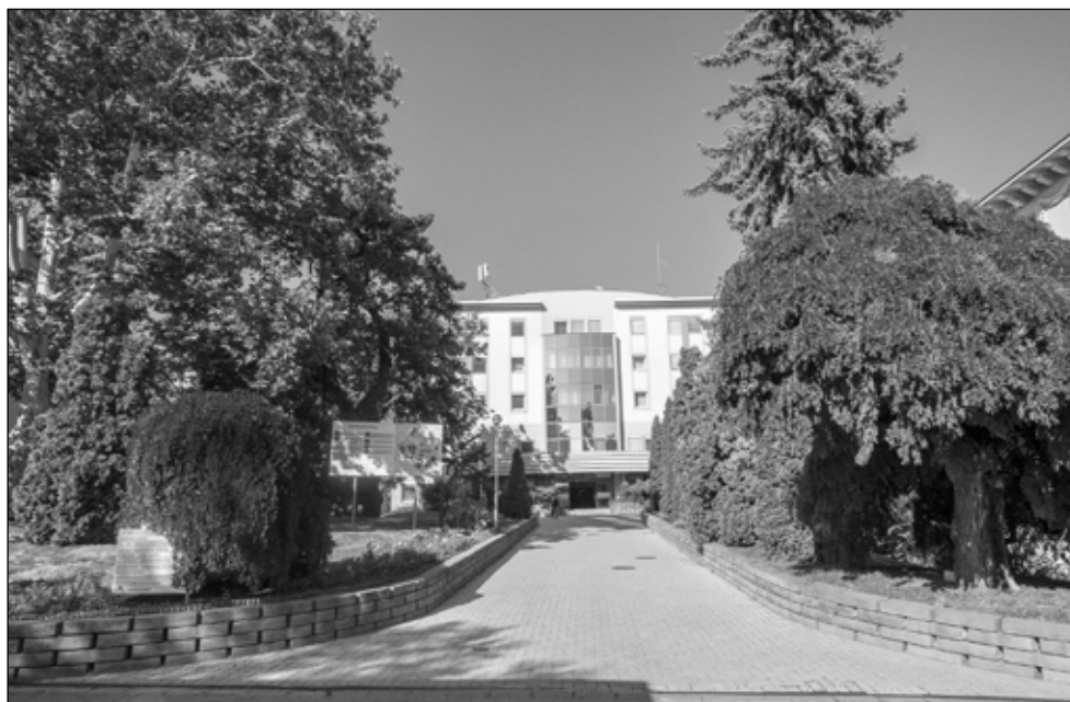
Az Erzsébet kórház főépülete a bejárat felől (Fotó: Griechisch Tamás)
