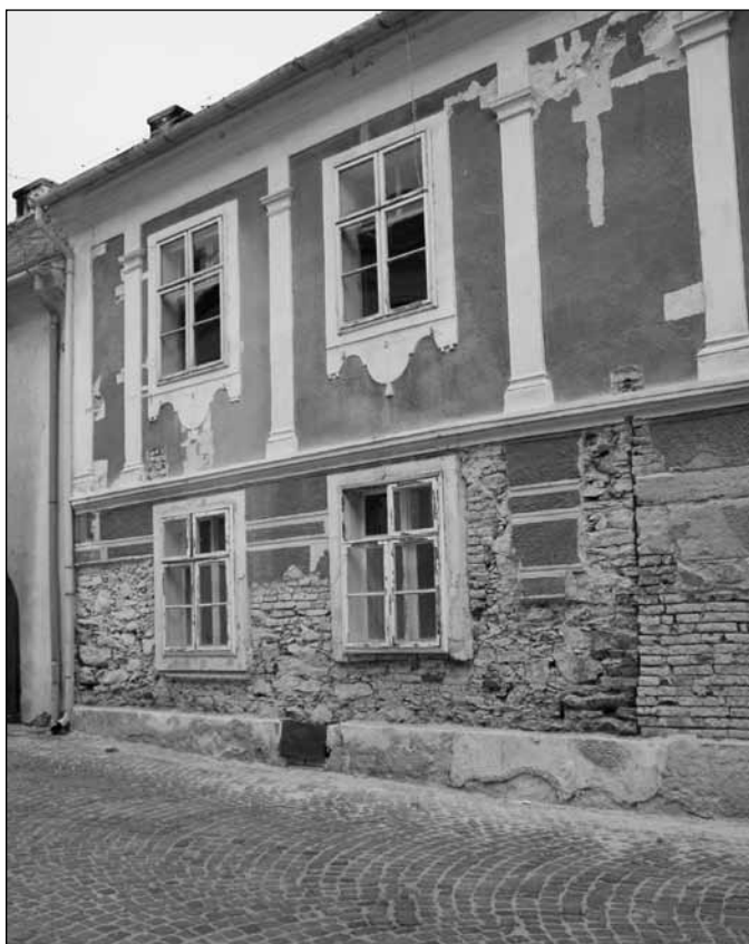
5. kép. Középkori telekhatárra eső falsarok feltárása a Chernel 2. számú épület földszintjén. Fotó: B. Benkhard Lilla 2007.
