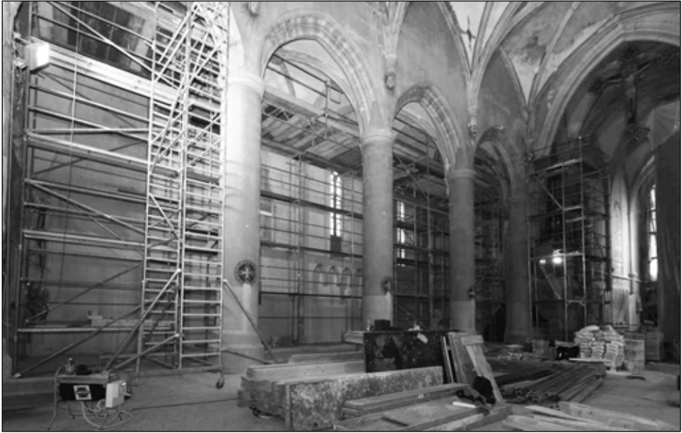
14. kép. Sopron, a Szent Mihály templom belső tere restaurálás közben, 2019 (Bolodár Zoltán felvétele)
