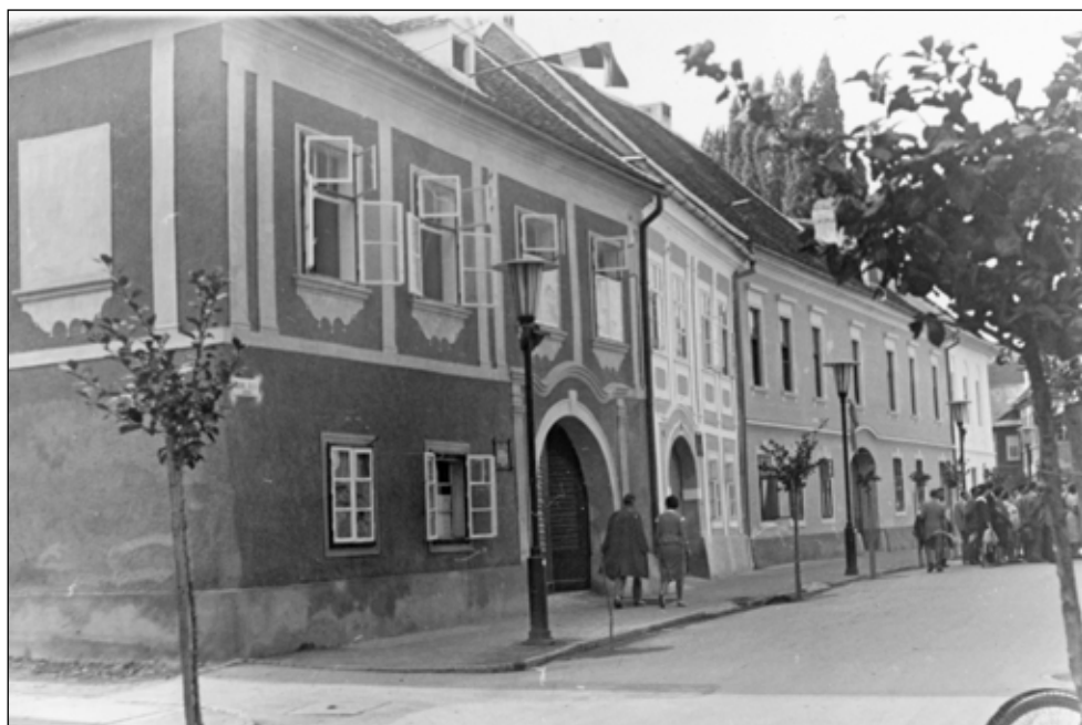
4. kép. A Rájnis utca 1, 3, 5. számú házak utcavonalra történő beépítése és egymás melletti homlokzata. Fotó: C. Harrach Erzsébet 1960-as évek vége
