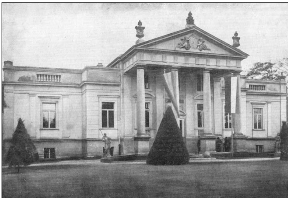
6. kép. A főbejárat homlokzata a Kultúrpalotává történő átalakításkor. Jelentős változás a bejárat középrizalitján 1907. után készített két ablak (Soproni Múzeum)
