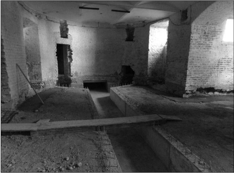
8. kép. Készülő légszűrő akna a volt konyha padlója alatt
