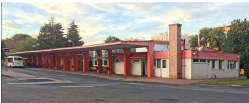
6. a-b ábra: Az épület külső képe egykor (Herczegh 1981, i. m. 95.) és ma. A műkö burkolatok bebugyolálása és az ide tervezett ablakosztás átalakítása révén az egyedi arculatú épületből kommersz, mondhatni jellegtelen formájú épület lett.
