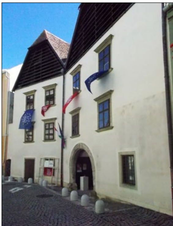
1. kép. A Kolostor utca 13. szám alatti épület
